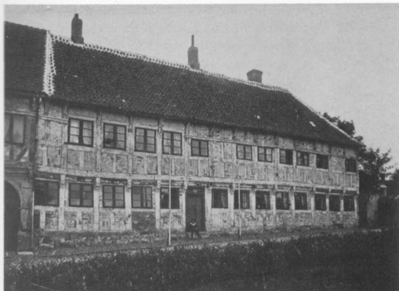
Fig. 1. Adelgade 19. Facaden er renset for puds og kalk i forbindelse med C. M. Smidts restaurering. I dag står buset med sorttjæret tømmer og tavl af ubehandlede teglsten. C. M. Smidt fot. 1906. Bybist. arkiv, Kalundborg.
