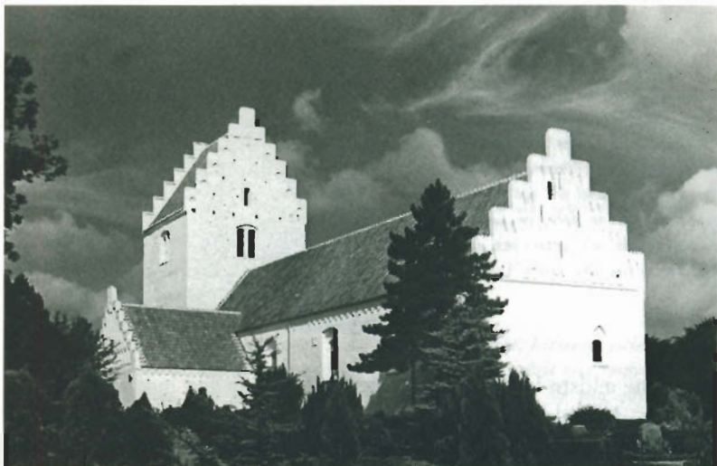
Fig. 15. Kundby kirke i Tuse bered med store fladbuede vinduer i både skib og kor. Korudvidelsen er sket kort efter 1500. I korgælden et lille fladbuet vindue i spidsbuet spejl. Fladbuede vinduer synes at være anvendt til små åbninger fra ca. 1300, mens større fladbuede vinduer bliver almindelige fra omkring 1400. Bl.a. er Kapitelhuset ved Roskilde domkirkes overetage fra ca. 1400 udstyret med sådanne fladbuede vinduer. De spidsbuede spejle om fladbuede vinduer synes lidt senere; snarest efter 1450 og de er den almindeligste type i klosterbyggeriet fra omkring 1500. Mie Jensen fot.
